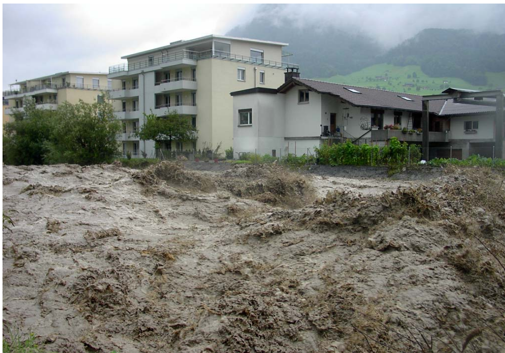
Abb. 7: Aa in Buochs. Das Bild vom 23. August 2005 zeigt deutlich, dass die Entlastungen oberhalb von Buochs unentbehrlich sind. Denn ohne die Entlastung von 60 m 3 /s oberhalb von Buochs wären hier über 200 m 3 /s statt den im Bild zu sehenden knapp 150 m 3 /s abgeflossen, was mit Sicherheit zu Dammbürchen geführt hätte.
