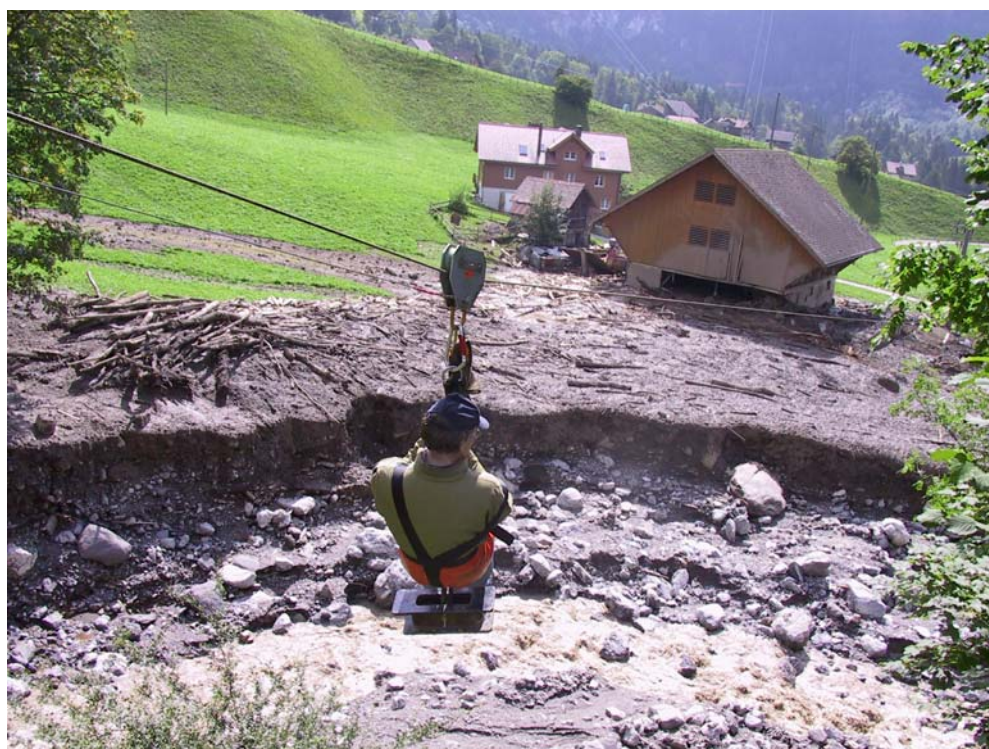
Abb. 9: Schäden des Haldibachs in Oberrickenbach
